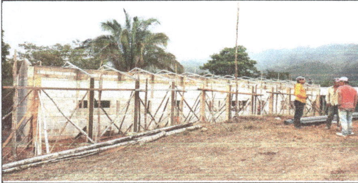
Foto 1: ESTRUCTURA DE TECHO
