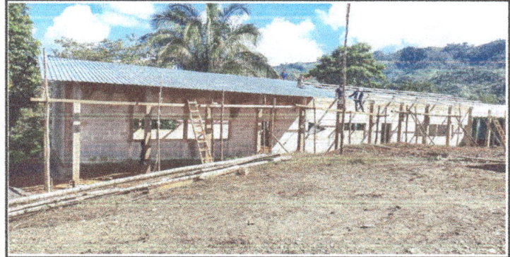
Foto 2: CUBIERTA DE LAMINA
